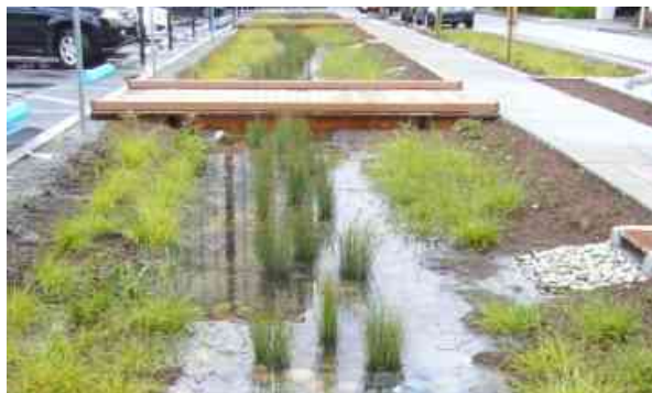
Рис 19. Природная система отвода ливневых вод Источник: Дождевой сад на Доннелли-авеню, Flowstobay.org
