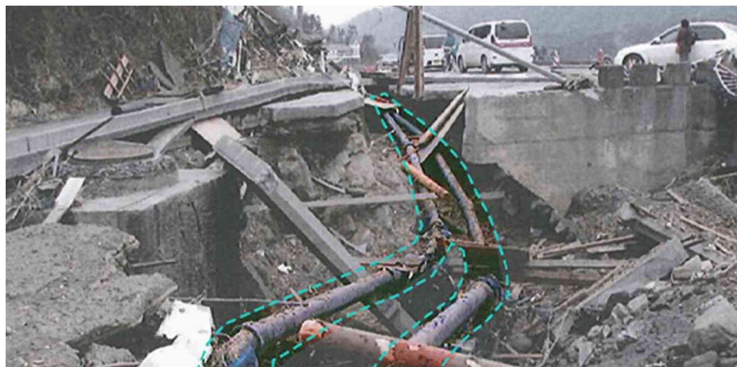
Рис 26. Сейсмостойкие трубы из высокопрочного чугуна, обнажившиеся после землетрясения 2011 года в Японии
